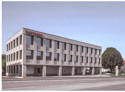
Belfaux FR: Deillon Delley architectes.
