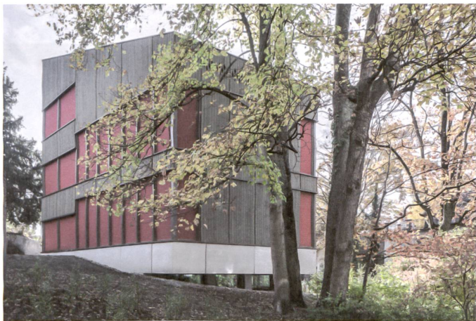
Hort Ilgen in Zürich: Die Gebäudeform folgt der maximalen Ausnutzung der Abstandsregeln. Eine Auskragung lässt Platz für die Baumwurzeln.
