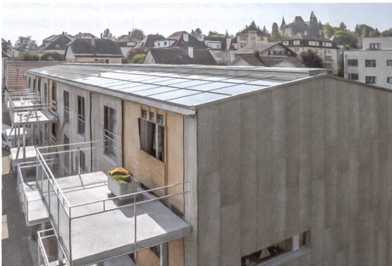
Hier noch im Bau: Das Dach prägt die Erscheinung des neuen Hauses mit.
