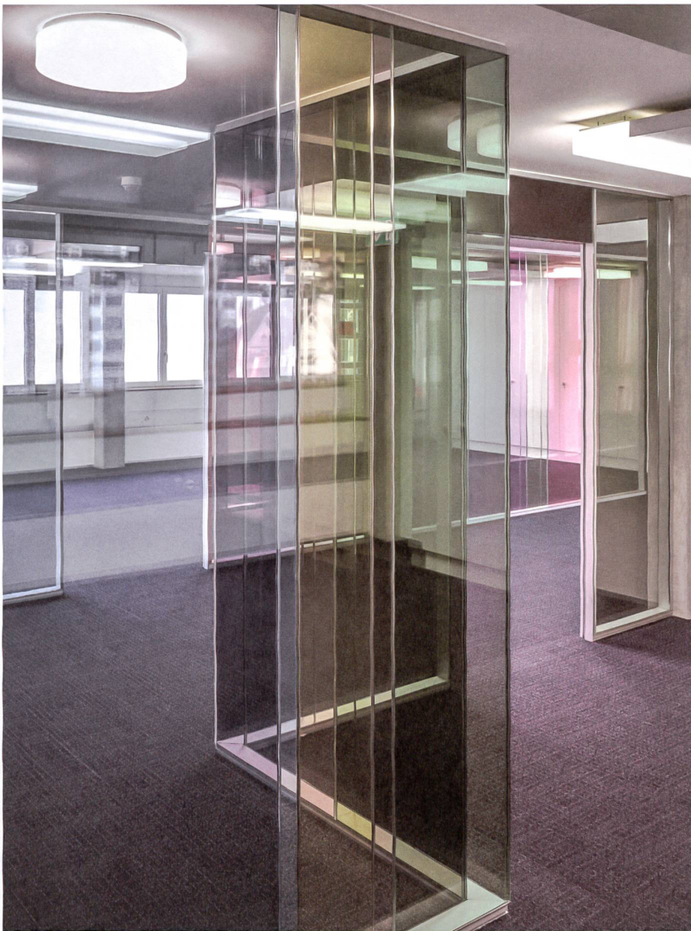
Die versetzbaren Glaswände der Büros spannen sich vom Teppichboden zur Decke.
