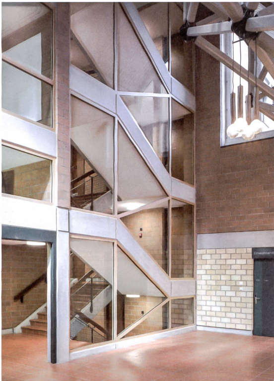
Die Eichenprofile der neuen Verglasung bringen Bewegung ins Treppenhaus. Hinter den Fenstern links befinden sich neue Besprechungsräume.
