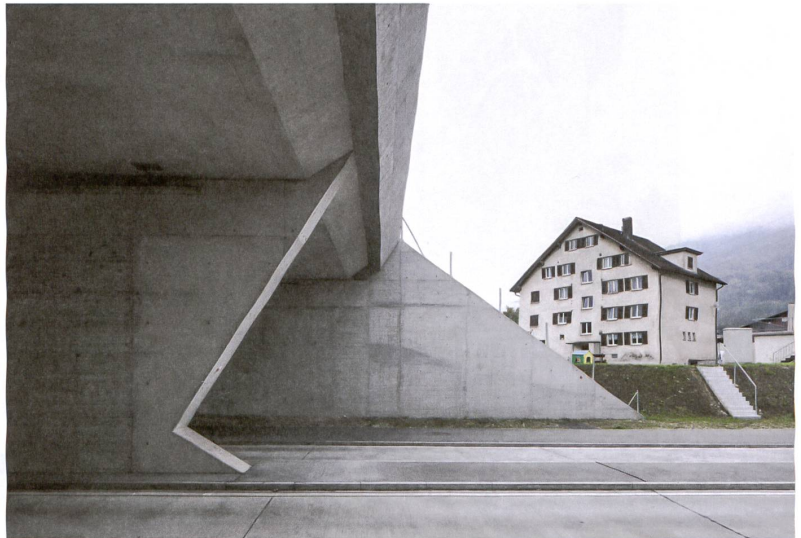
Unterführung Wysshus West: Der typische Konsolkopf der Brücke spannt sich zwischen den Flügelmauern auf.
