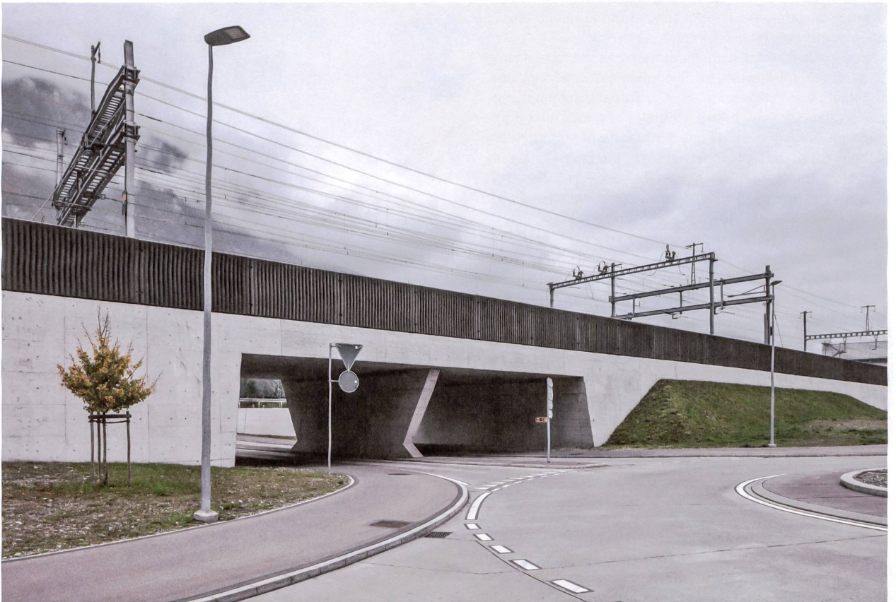
Unterführung Wysshus Ost: Der Sturz der Brücke ist Teil der parallel zu den Gleisen geführten Stützmauern.
