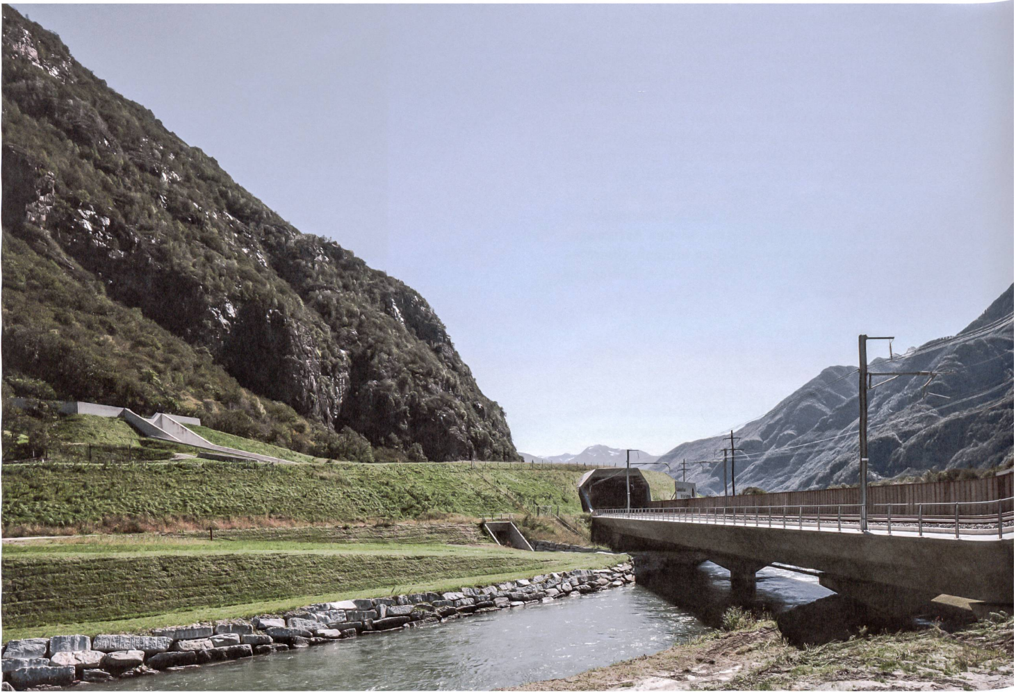
Einheitliche Sprache: Die Brücke über die Froda führt in den Tagbautunnel «Giustizia», daneben der schützende Geröllfang «Riale Stabiello».
