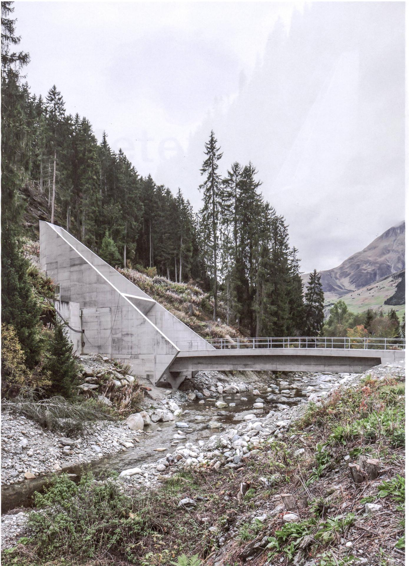
Multifunktionale Zufahrt: Das Portalbauwerk bei Sedrun verbindet Zuluftkanal, Lawinenschutz und Zufahrt zu den 800 Meter tiefen Schächten im Berginneren.
