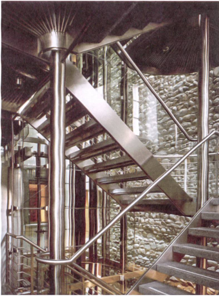
Hotel Widder, Zürich: Stahltreppe und Lift kontrastieren zum historischen Bau.
