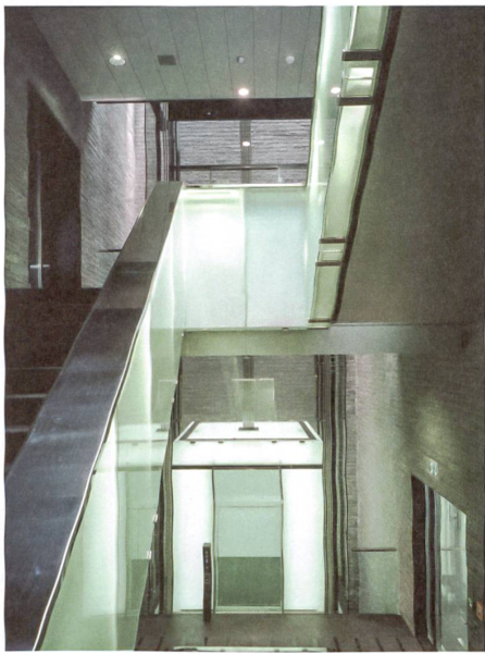
Fifa-Hauptsitz, Zürich: Die Treppe und der Lift sind als Lichtkörper im von oben belichteten Steinturm gestaltet.
