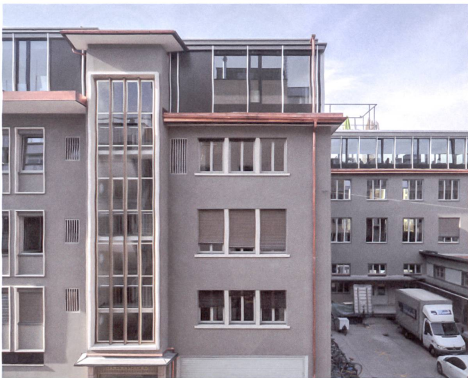
Die Materialien und die Proportionen der Aufstockung an der Binzstrasse in Zürich orientieren sich am Bestand.
