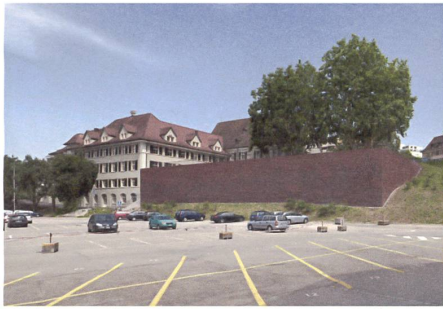
Hinter der mächtigen Backsteinmauer liegen die Archivräume. Foto: Jürg Zimmermann
