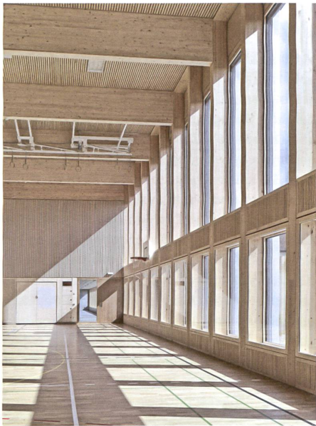
Die Turnhallenaufstockung in Holzelement-Bauweise. Fotos: Jürg Zimmermann
