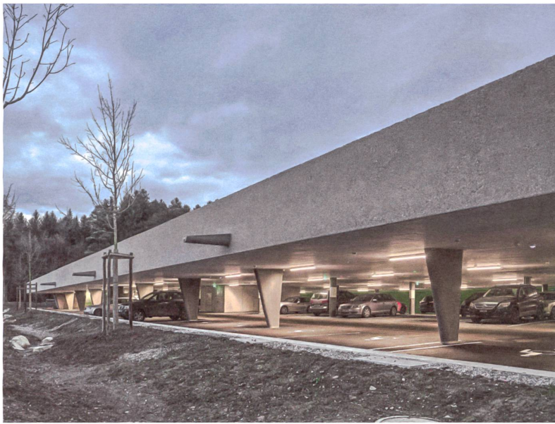
V-förmige Stützen und die Wasserspeier prägen die lange Front des Parkhauses. Fotos: Roger Frei
