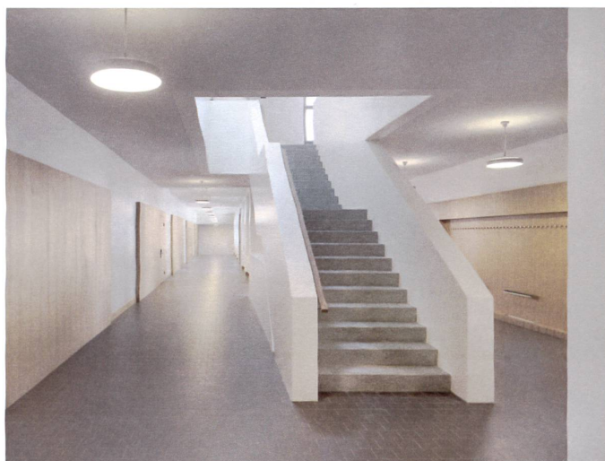
Die neue Haupttreppe im Zentrum sorgt für eine gute Orientierung.
