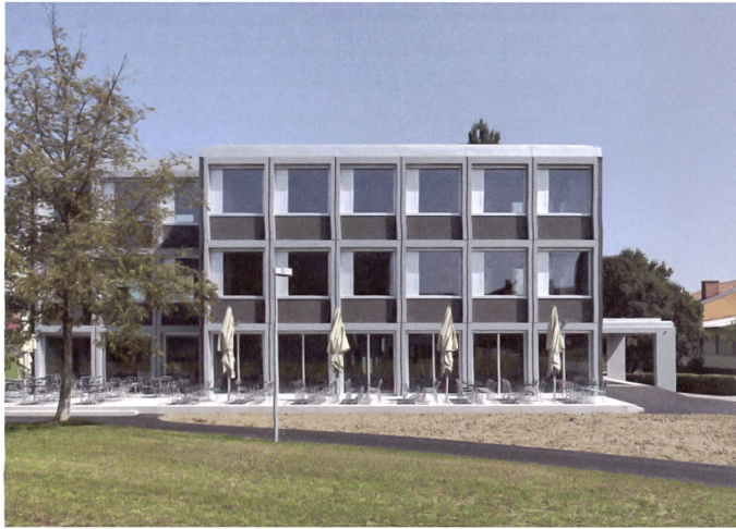
Der «Varielbau» der Kantonsschule Romanshorn hat ein neues Gesicht bekommen.
