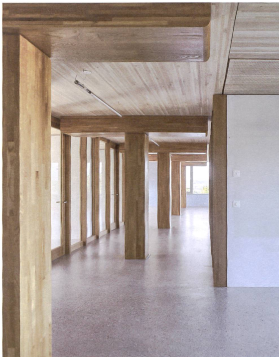
Unmittelbar hinter dem Eingang steht eine Reihe mannsdicker Eichenstützen mit Sattelholz. Fotos: Roland Bernath
