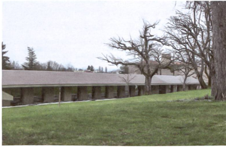
Raumhohe Fenster auf der Südseite. Rechts der Ergänzungsbau mit dem noch helleren Dach.
