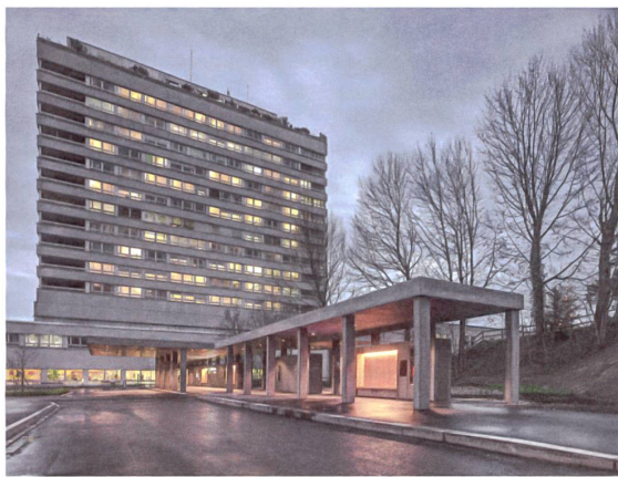
Vor dem Hauptzugang zum Kantonsspital Frauenfeld: Das weit auskragende Dach schützt die Postautopassagiere.
