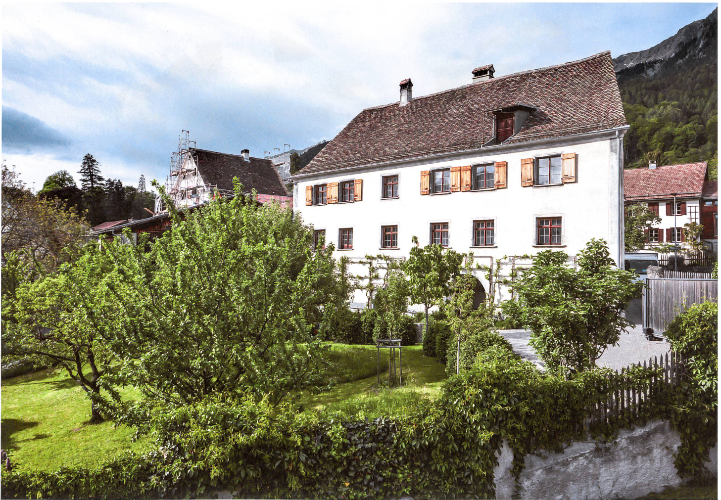
Das Haus von Moos, gebaut 1722 und renoviert 2008 von Michael Hemmi und Michele Vassella, mit Zier- und Nutzgarten, umsäumt von Mauern.
