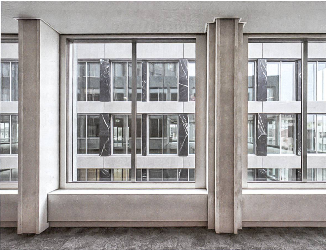
Die Kanten gliedern die Betonstützen, Naturstein verziert die Fassade des Nebenbaus. Foto: Roger Frei
