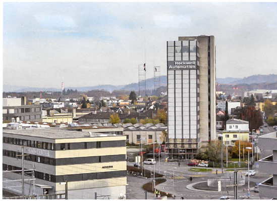
Das Hochhaus der Firma Rockwell in Aarau: Am 8. März 2013 wurde es gesprengt. Foto: Archiv Schneider & Schneider Architekten
