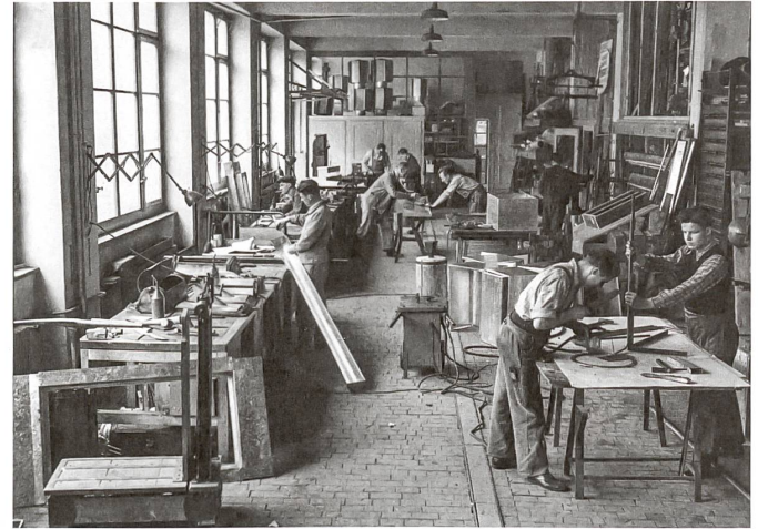
An ihrem neuen Arbeitsort in Zürich-Brunau falzen und kanten die Handwerker in hellen, grosszügigen Werkhallen.
