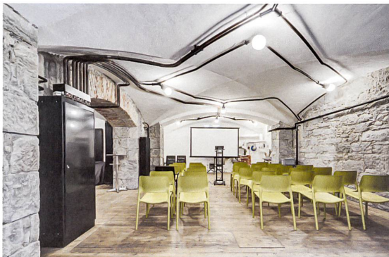
Im Keller führen Rohre Strom nach oben, andere münden in Fassungen.
