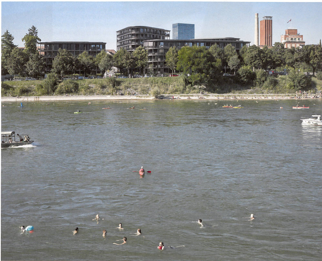
Blick über den Basler Rhein: Dank dreieckiger Häuser blicken alle 86 Wohnungen aneinander vorbei und auf das Wasser.
