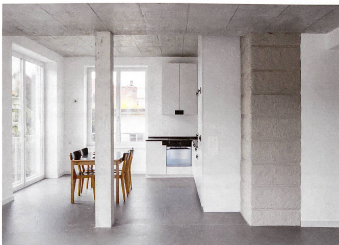
Früher aussen, nun Teil von Küche und Wohnraum: die steinerne Hausecke.
