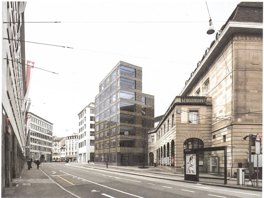
Der geplante Neubau des Amtes für Umwelt und Energie des Kantons Basel Stadt an der Spiegelgasse.
