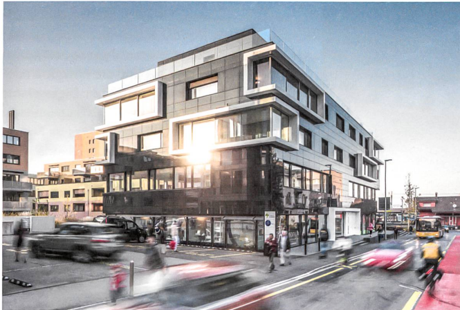
Die Fassade des Wohn- und Geschäftshauses in Pfäffikon SZ ist auch ein Kraftwerk: Die schwarzen Fotovoltaikmodule produzieren genug Strom für das Gebäude.
