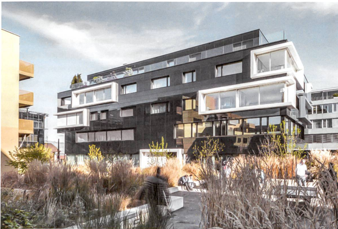
Die Rückseite des auffällig schwarz-weißen Gebäudes orientiert sich zum neu angelegten Stadtgarten in Pfäffikon hin.
