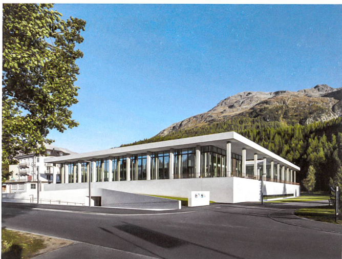
Die umlaufende Säulenreihe des Hallenbads in St. Moritz trägt die grosse Dachplatte und erinnert an einen Tempel.
