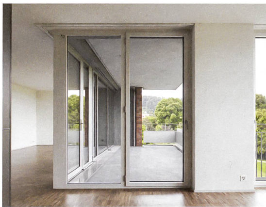
Die Hauptwohnräume: Die Ausdrehung orientiert die Wohnungen aneinander vorbei und in die landschaftliche Tiefe statt zum Gegenüber.
