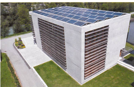
Das Bürohaus Cavigelli in Ilanz produziert mehr als doppelt so viel Energie, als es braucht. Projekt: Vincenz Weishaupt Architekten
