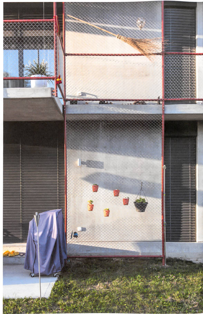
Die Gerüste werden bald bewachsen sein.
