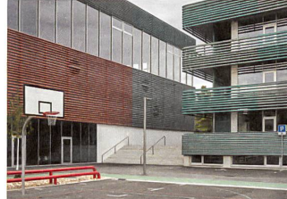
Schulhaus Gartenhof, Allschwil BUR Architekten
