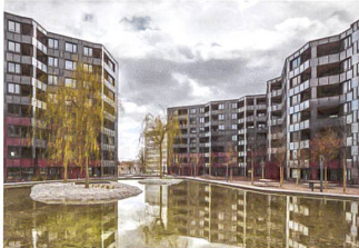
Wohnüberbauung Guggach, Zürich BS+EMI Architektenpartner
