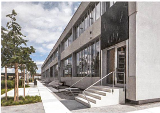
Schulanlage Blumenfeld, Zürich Oester Pfenninger Architekten
