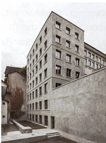
Wohnhaus, Baden Meier Leder Architekten
