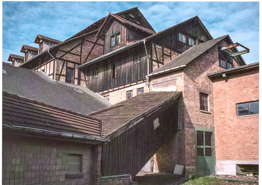
Ziegelei Berg, ein denkmalpflegerisch bedeutendes Ensemble. Fotos: Katalin Deér
