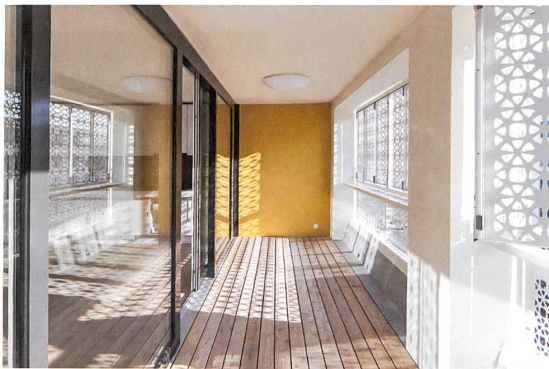
Fensterläden filtern das Licht der Loggien von Duplex Architekten.
