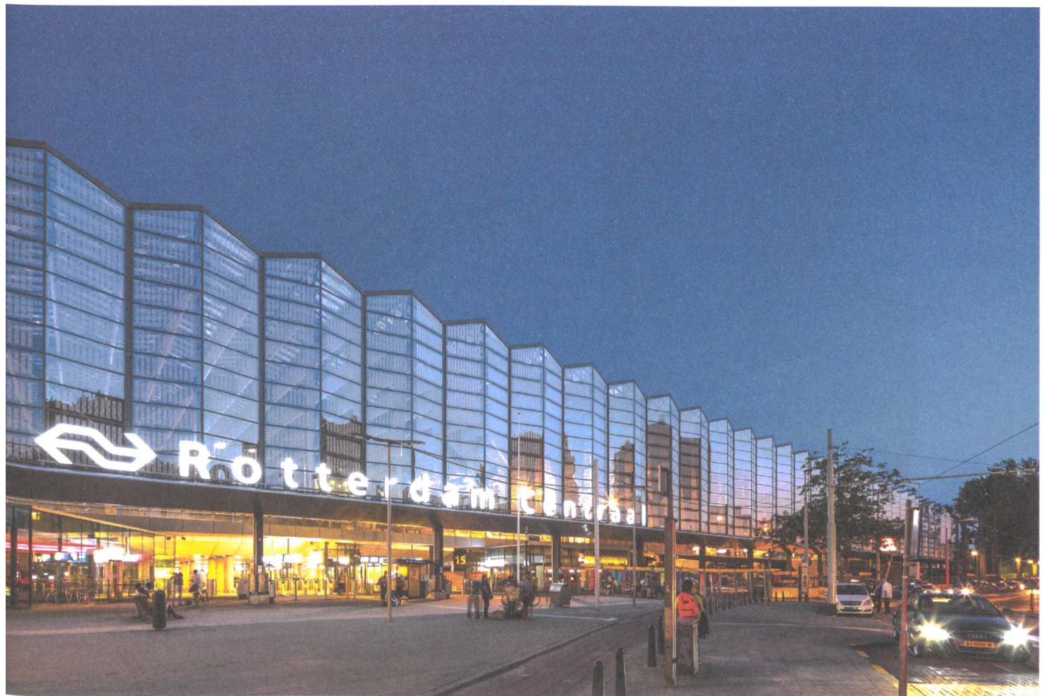
Das Nordportal ist klar die Rückseite des neuen Bahnhofs. Das Faltdach der Bahnsteighalle geht hier in die Vertikale über.
