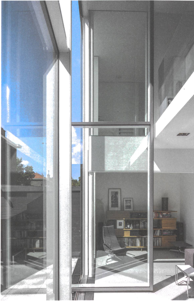
Die Fläche, die die fast zwei Meter breite Türe zum Öffnen braucht, definiert die Tiefe des Rücksprungs im oberen Geschoss, wo das Heimbüro liegt.
