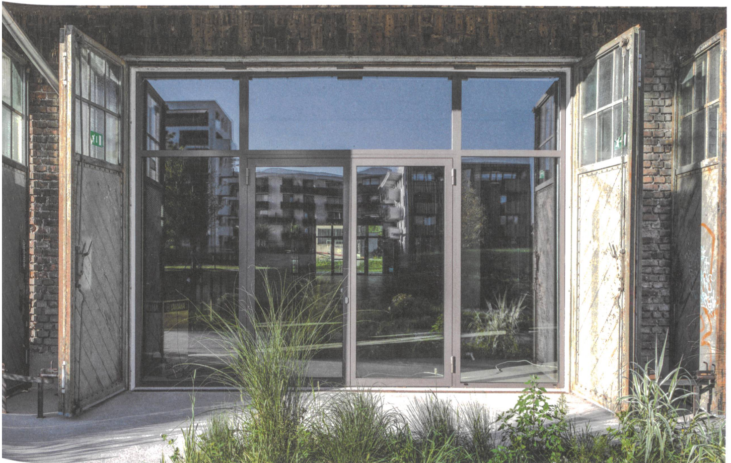
42 innenliegende Glasfelder bilden die neue Klimaschicht im Erdgeschoss. Die grossen Öffnungen und Tore erinnern an die Nutzung der Panzerhalle als Werkstatt.
