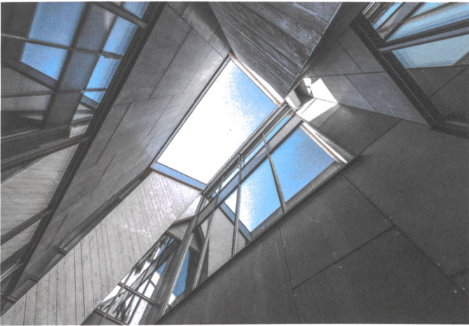
Hoher Lichtkamin: Neue Atrien führen in zentral erschlossenen Abschnitten das Tageslicht bis in die Eingangsebene.
