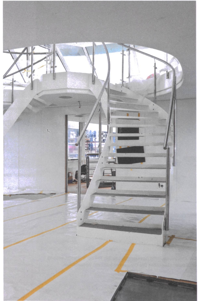
Das Entree – hier noch im Bau – orientiert sich an Eingangshallen einstiger Grandhotels.
