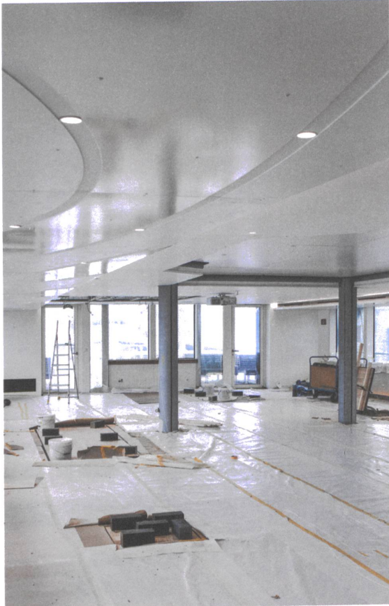
Der Zweitklass-Salon des Hauptdecks: Ein Teil der Decke ist entlang der Säulen absenkbar. Die Ornamente imitieren Wasserringe.
