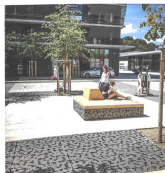
Für die Baumscheiben und die Bänke werden identische Platten verwendet.
