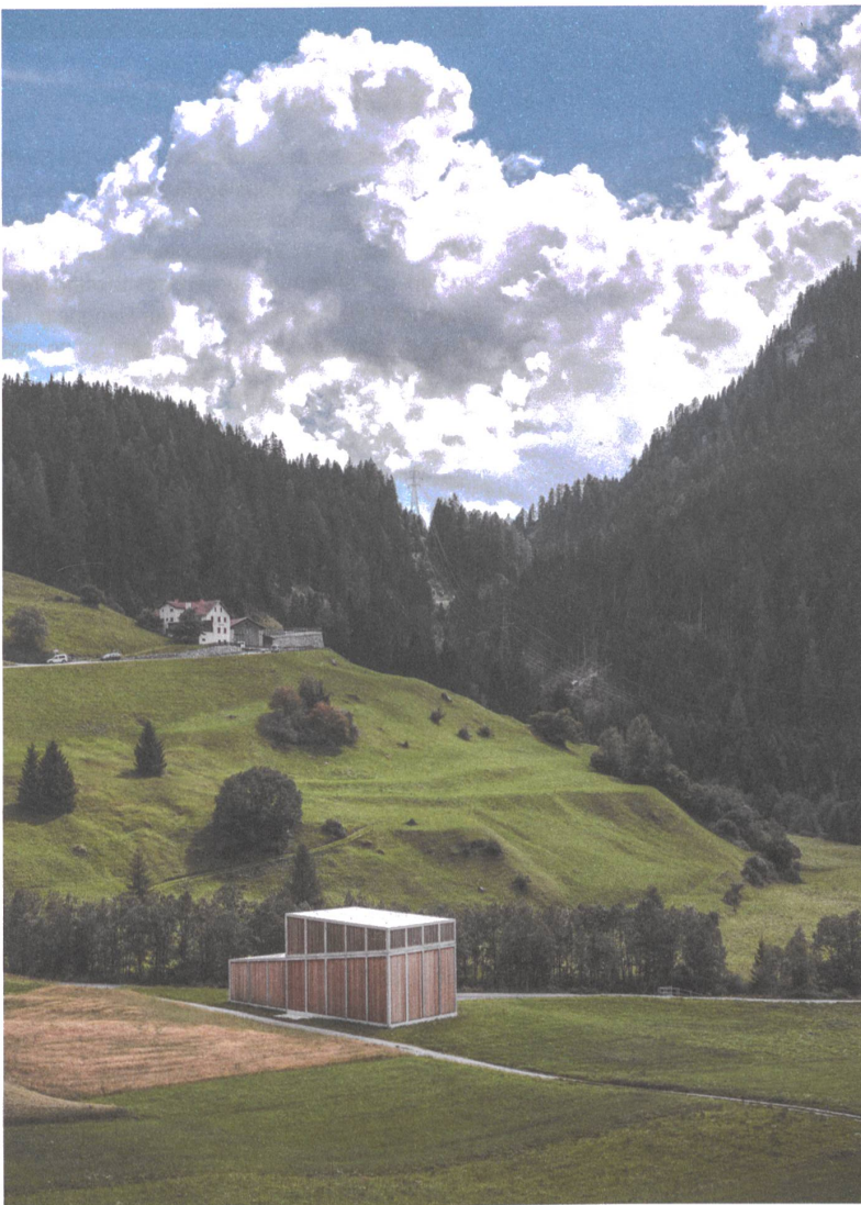
Lärchenbohlen zwischen Betonrippen geben dem Wasserkraftwerk «Ragn d'Err» ein ruhiges Gesicht.
