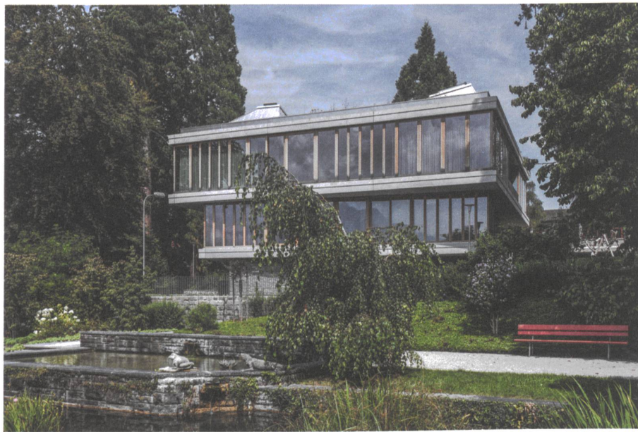
Die Geschosse des Neubaus der Schulanlage Felsberg in Luzern rotieren nach oben zum voralpinen Panorama und zur Innenstadt. Sie sind unten kleiner, damit die Wurzeln der Mammutbäume weiterwachsen können.
