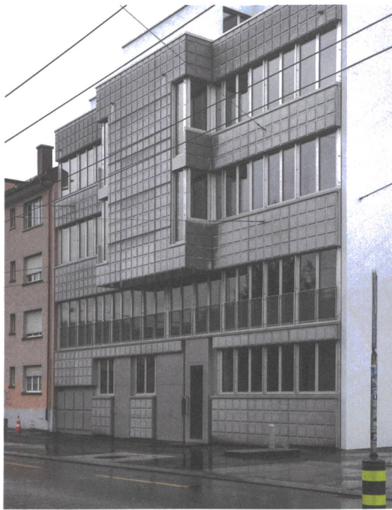
Das letzte städtische Haus von Zürich steht gegenüber des Schlachthofs. Die Bossen seiner Fassade sind aus dünnem Faserbeton.
