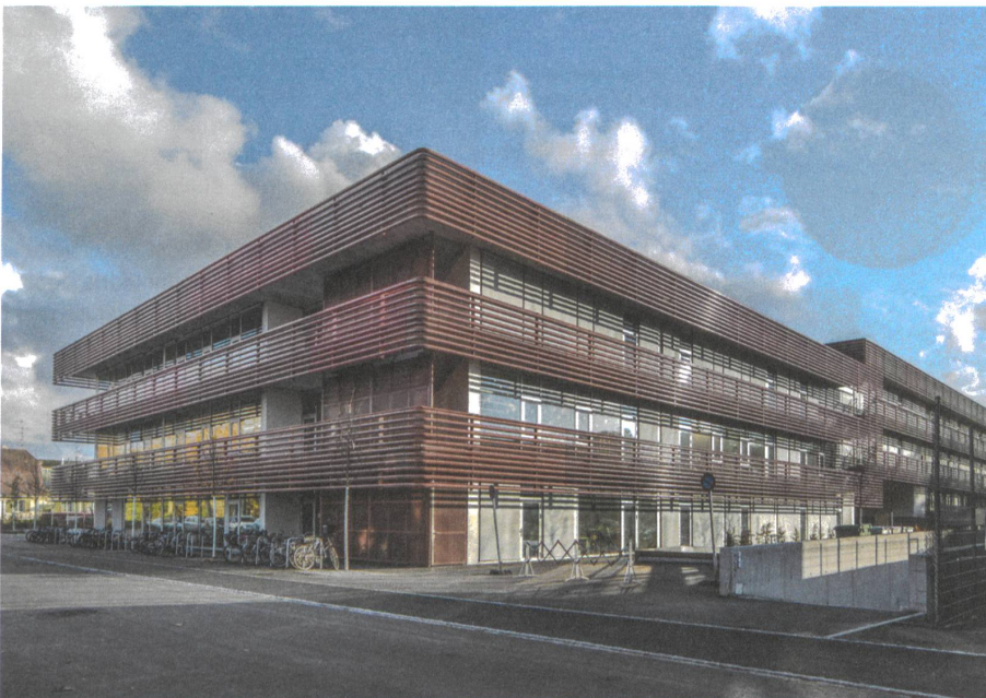
Bunte Metallrohre umrunden die Schule Gartenhof in Allschwil.
