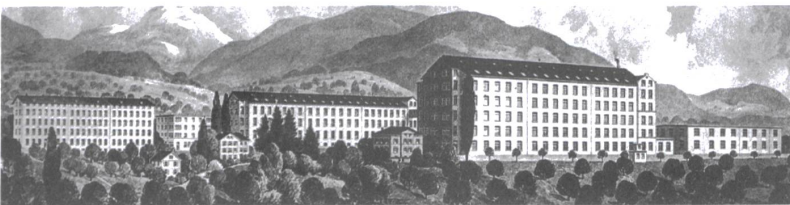
Mit der Perspektive nahm es der Zeichner nicht so genau, Hauptsache, alle Gebäude der Stoffel-Fabrik passten aufs Bild. Bild: Archiv Alte Textilfabrik Stoffel
