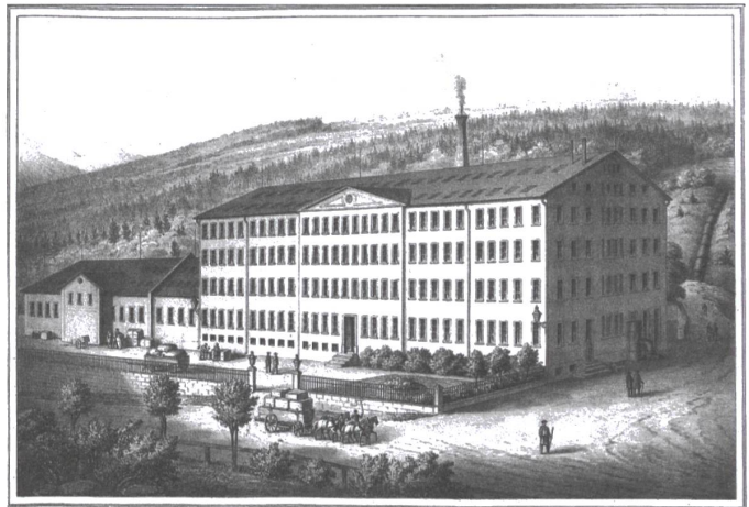
1866 nimmt die Spinnerei Schiltsbach – die spätere Spinnerei Spoerry – den Betrieb auf. Noch fehlt der Turm in der Mitte des Fabrikgebäudes. Grafik: Archiv Innobas
