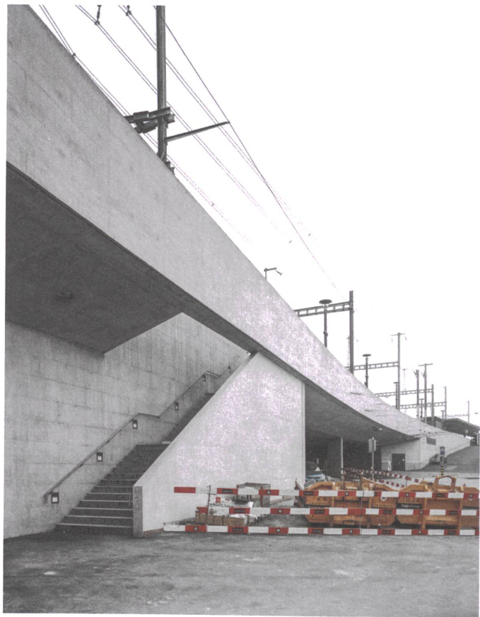
Der Zugang von der Friesstrasse zum Gleis 8 ist elegant in die Stützmauer eingelassen. Bei der Unterführung Schaffhauserstrasse sind die Bauarbeiten noch im Gang.
