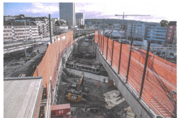
Bauphase 3: Eine schmale Inselbaustelle, durch die erst noch das Tram fährt – hier wird an der Brücke für die Gleise 5 und 6 gebaut.
