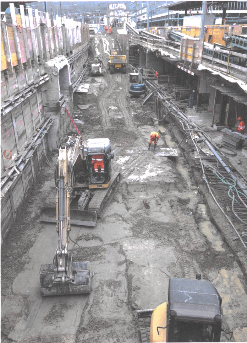
Bauphase 2: Das neue Gleis 8 ist schon in Betrieb rechts. Auf einer Inselbaustelle entstehen die Quartierverbindung, die Personenunterführung Mitte und der neue Mittelperron der Gleise 6 und 7.
