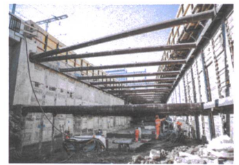
Bauphase 2: Aufwendige Verstrebungen halten beim künftigen Zugang Andreasstrasse die Bahndämme an ihrem Ort.
