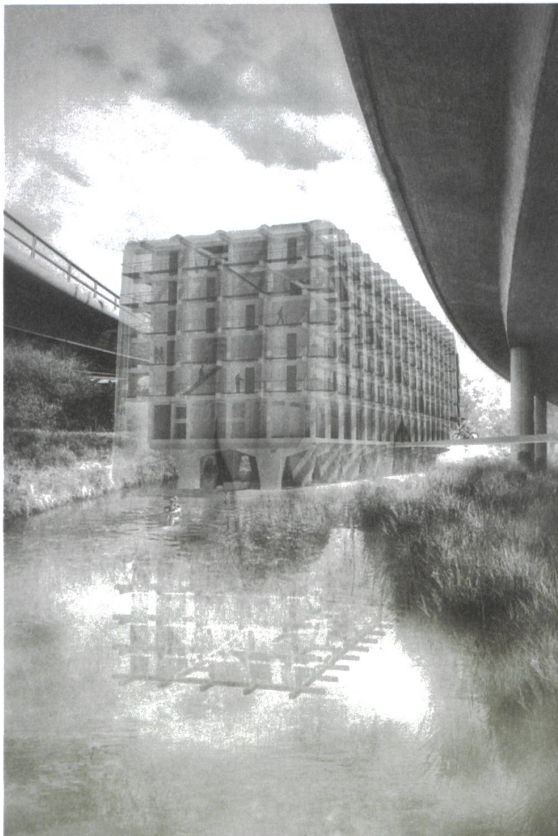
Hinter einer transparenten Hülle steckt eine robuste Betonstruktur.
