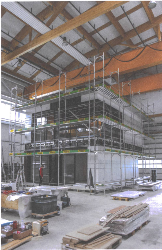
Renggli baute das Moduleinfamilienhaus testhalber in der Halle auf. | Renggli a fait un montage test en atelier de la maison individuelle. Foto | Photo: Renggli
