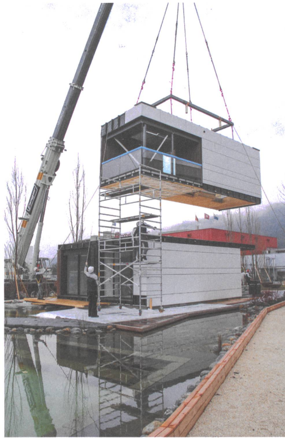
Danach wurde das Gebäude in Rothrist vor Ort zusammengesetzt. | Le bâtiment fut ensuite assemblé sur place à Rothrist. Foto | Photo: Renggli
