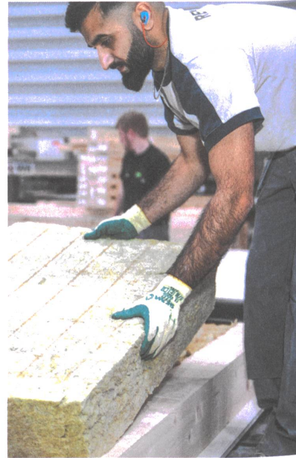
Ein Arbeiter legt die Dämmung in die Wandkonstruktion. | Un ouvrier pose l'isolation dans la construction du mur.
