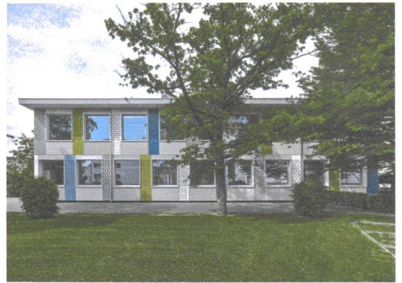
5 Die fröhliche Fassadengestaltung verwischt die Zusammensetzung aus Modulen. | l'aménagement de la façade aux couleurs vives estompe l'assemblage de modules.
