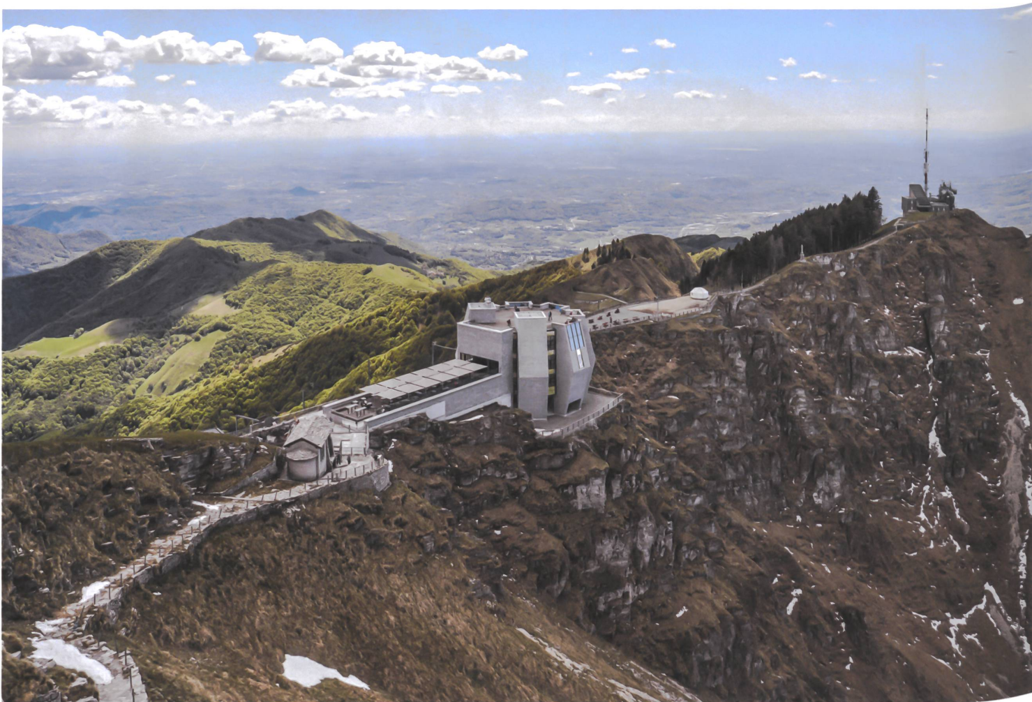
Das punktsymmetrische Gebäude ruht auf dem Grat, der die Situation und die Aussicht zweiteilt.
