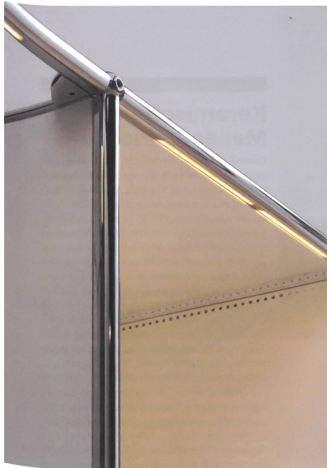
Die Lichtelemente sind bündig in die Rohre integriert.
