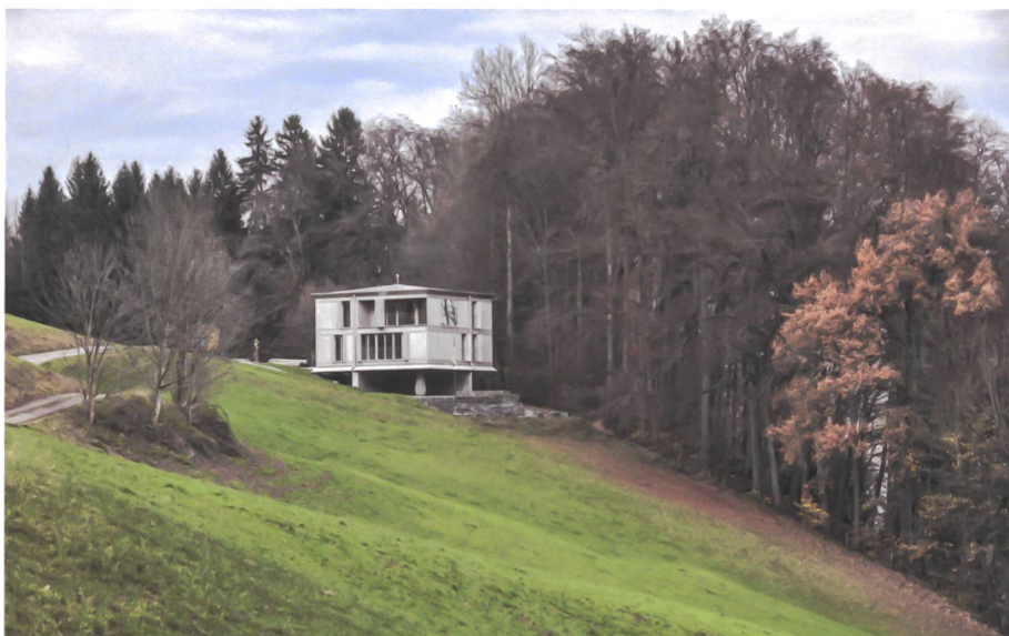
Pfadfinderheim vor Waldrand: Der Baukörper balanciert am Hang von Horgen. Die Hinkelstein-Stütze ist Kunst.
