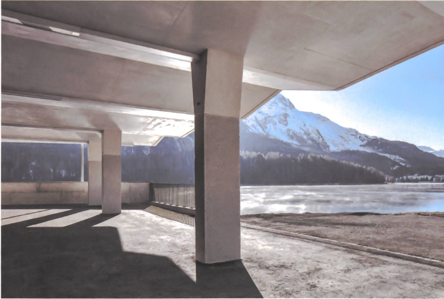
Im unteren Teil sind die Träger für das gefaltete Dach gestockt als Referenz an den alten Bahnhof.
