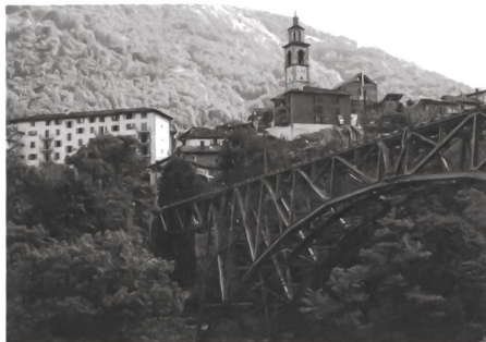
Il Ponte in ferro della «Centovallina»; ca. 1920.
