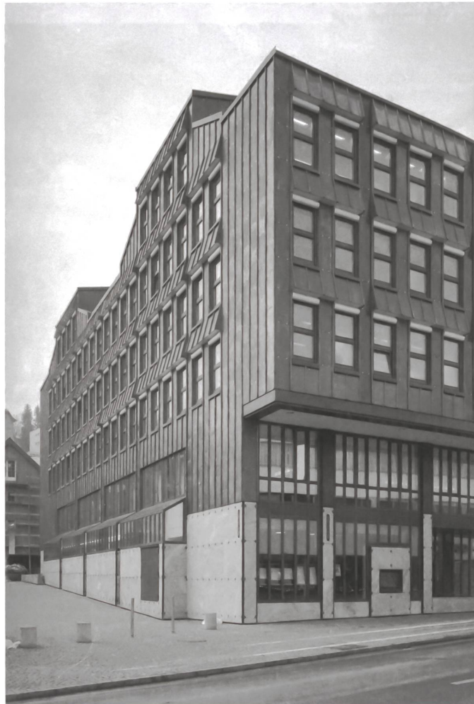
Nachahmende Interpretation: Ernst Gisel, 1981, Kantonbank am Obstmarkt, Herisau. Eine spätgotische Kirche und Bürgerhäuser aus dem 18. Jahrhundert flankieren das aus einem zweistufigen Wettbewerb hervorgegangene Bankgebäude. Die Architektur ist selbstbewusst, interpretiert aber den Standort und die regionale Bautradition mit neuzeitlichen Mitteln. Massstab, Struktur und Klebdächer der Bleifassade sind auf diese Weise hergeleitet. Blei patiniert hell, sodass sich seine Farbigkeit an die Fassaden verschindelter Häuser anlehnt. Im Gegensatz dazu sind die tragenden Stützen mit nachdunkelndem Kupferblech verkleidet. Sie erinnern an die Pilaster, die das Fronttäger vieler Appenzeller Bürgerhäuser gliedern und auf den dahinter liegenden Strickbau verweisen. Fotos links: Gäbi Lutz, GTA-Archiv, ETH Zürich, Vorlass Ernst Gisel. Foto rechts: Vorlass Georg Gisel
