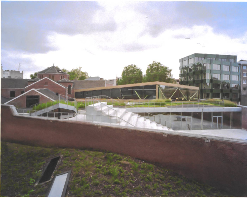
Universität Hasselt: Das einstige Gefängnis bauten Noa Architekten zu erlebnisreichen Räumen um. Rechts im Hintergrund steht ihr gläsernes Verwaltungsgebäude. Fotos: Kim Zwarts
