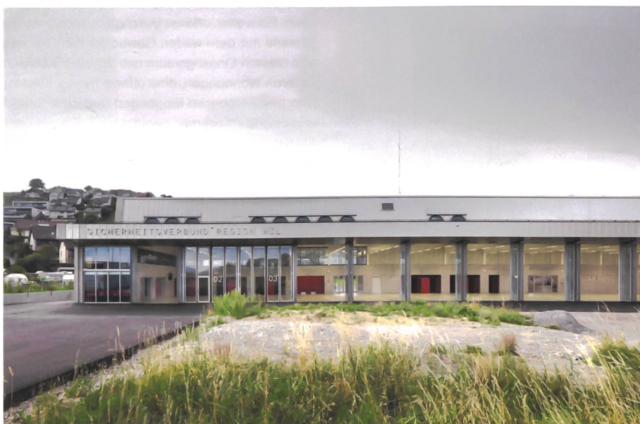
Hier noch ohne die roten Autos der Feuerwehr Wil: Die gläserne Front der Einstellhalle ist fast hundert Meter lang.
