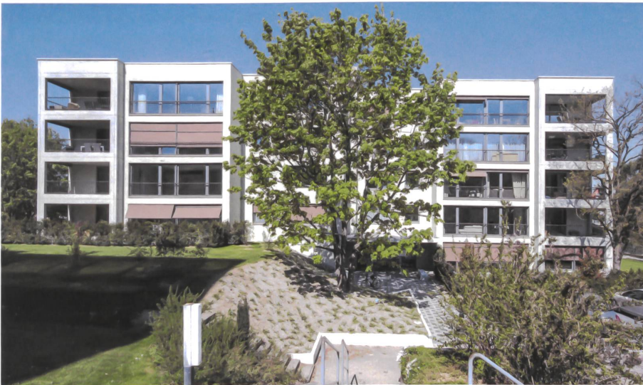
Loggien und grosse Fenster prägen das Mehrfamilienhaus in Oberwil heute.
