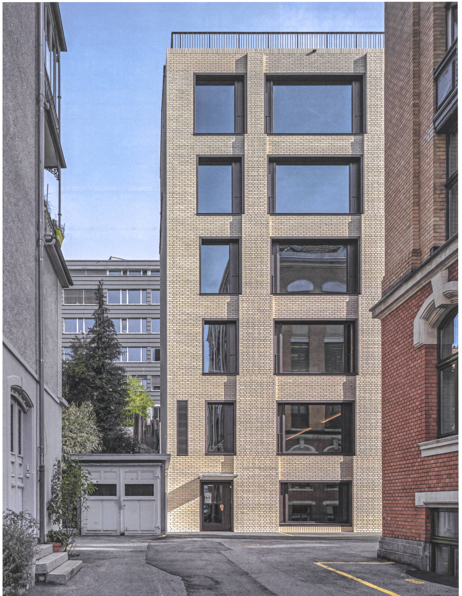
Gemauerte Kraft im Stickerei-Quartier in St. Gallen: Pilaster und Brüstungen des Neubaus werden nach oben schmaler, die Fenster grösser.
