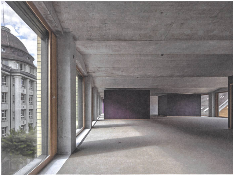
Das Faltwerk der Betondecken prägt die Räume.
