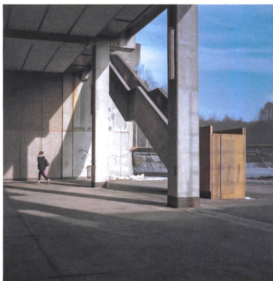
Die Treppe beim Eingang muss einem neuen Hauptzugang weichen.
