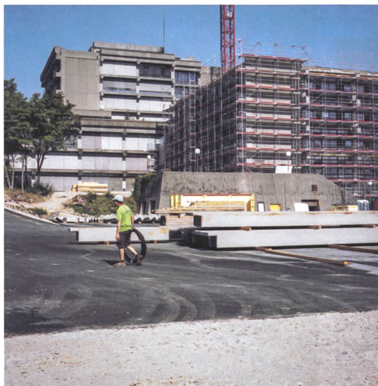
Auf dem Sportplatz sanieren Arbeiter die Betonelemente.
