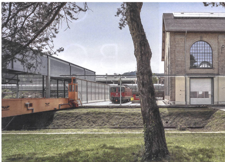
Eine Verschiebeeinrichtung verbindet die SBB-Hallen in Zürich-Altstetten mit der neuen Halle links.
