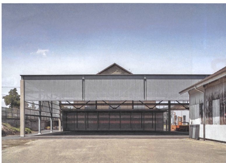
Noch lagert kein Material hinter der weiten, stützenfreien Zufahrt der 52 Meter langen Halle.
