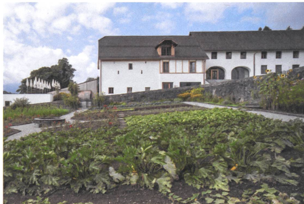
Das Dach wurde wieder mit den alten Ziegeln eingedeckt. | The roof was covered with the old tiles.
