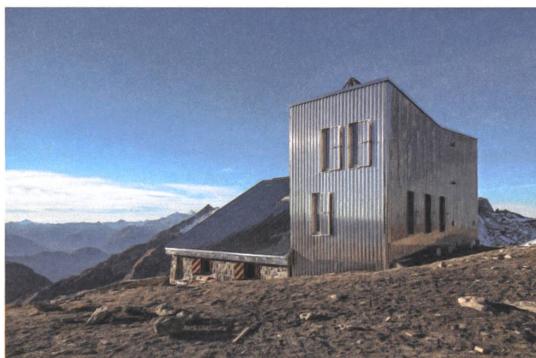
Der Anbau nimmt die Technik auf. | Room for technology in the extension.
