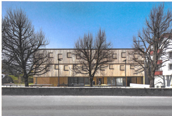
19 Die kleinen Fenster des Pflegewohnheims erinnern an die Häuser der Region. | The small windows of the nursing home are reminiscent of the typical regional houses.
