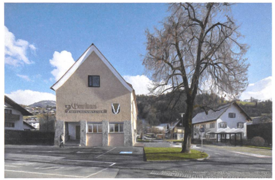
17 Sanft umgebautes Gemeindeamt. | Gentle renovation of the town hall.
