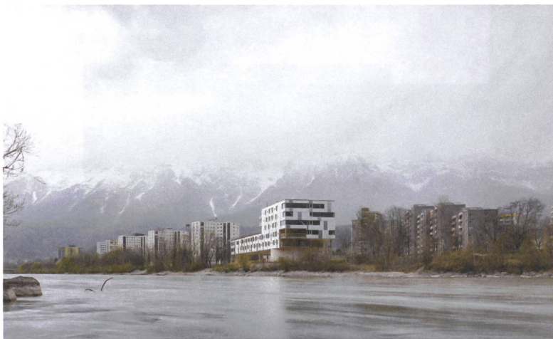
21 Das Alterswohnheim steht am Ufer des Inns. | Retirement home at the Inn river waterfront. Foto: Lukas Schaller
