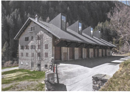
6 Kunstdepot im früheren Zeughaus. | Art warehouse in a former armoury.
