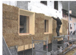
14 Isolation mit bis zu 80 Zentimetern Stroh. | Up to 80 cm straw insulation.
