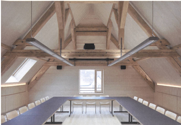
17 Gemeindesaal im Dachgeschoss. | Community hall on the attic floor. Fotos: David Schreyer
