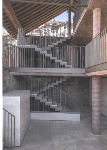
3 Offene Wände unter dem schützenden Dach. | Open walls underneath the protecting roof.
