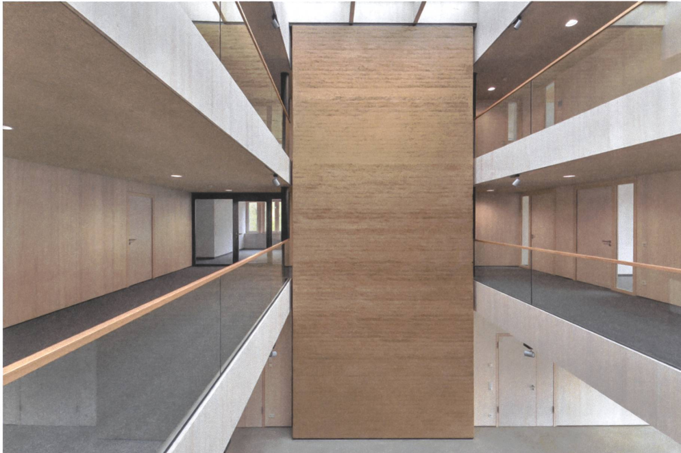
28 Eine Mauer aus Stampflehm gleicht die Luftfeuchtigkeit im Atrium aus. | A rammed clay wall balances the air humidity in the atrium.
