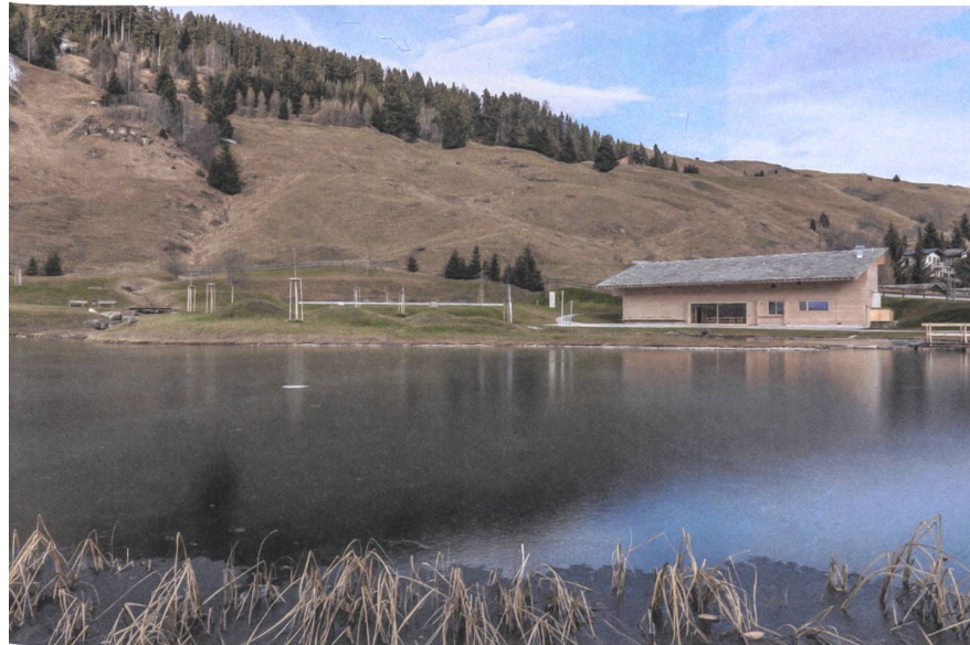
9 Das Badehaus als massiver Strickbau. | The bathhouse is a solid log construction. Foto: Lucia Degonda
