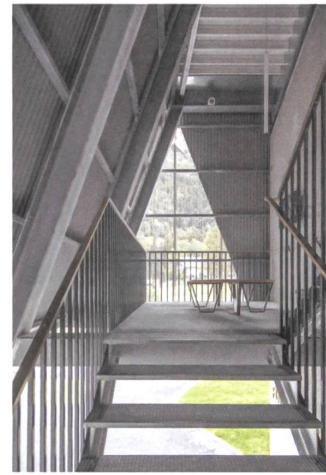
12 Zugang durch die Stahlkonstruktion. | Access through the steel construction.
