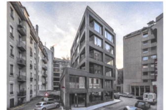
Mehrfamilienhaus rue Barton, Genf LRS architectes, Genf
