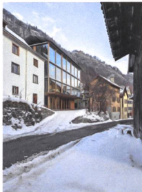
Ateliererweiterung, Haldenstein Atelier Peter Zumthor
