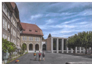
Turnhallen Schulhaus Hermesbühl, Solothurn Peter Moor, Zürich
