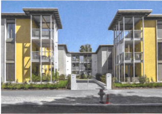
Ersatzneubau Schönauring, Zürich Knapkiewicz&Fickert, Zürich
