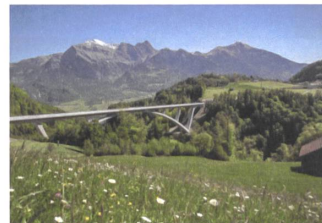
Taminabrücke, Valens-Pfäfers Leonhardt, André und Partner Ingenieure, Stuttgart
