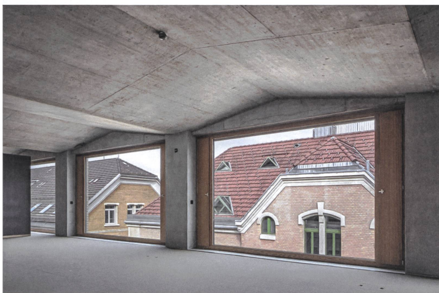
Eine gefaltete Betondecke prägt die offenen Büroräume.
